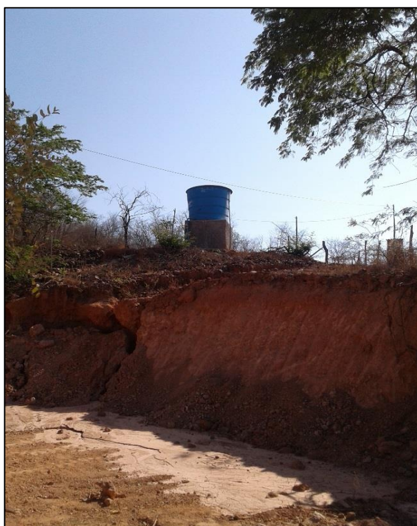
Figura 75 – REL 3 do povoado Água Quente. Fonte: DRZ – Geotecnologia e Consultoria, 2017.
