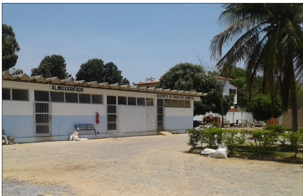
Figura 20 – Almoxarifado e depósito de produtos químicos.
