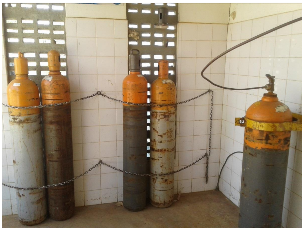
Figura 44 – Aplicação de cloro gás no tratamento. Fonte: DRZ – Geotecnologia e Consultoria, 2017.
