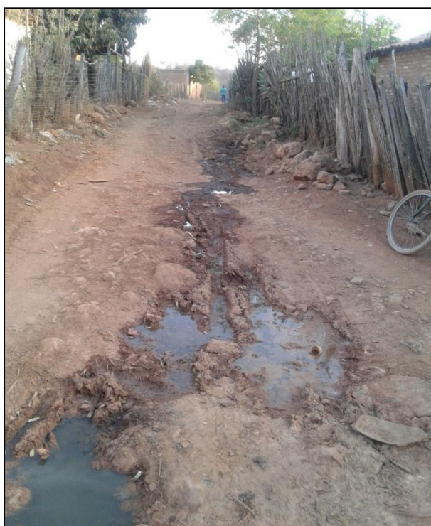
Figura 116 – Lançamento de esgoto em via pública. Fonte: DRZ Geotecnologia e Consultoria, 2017.
