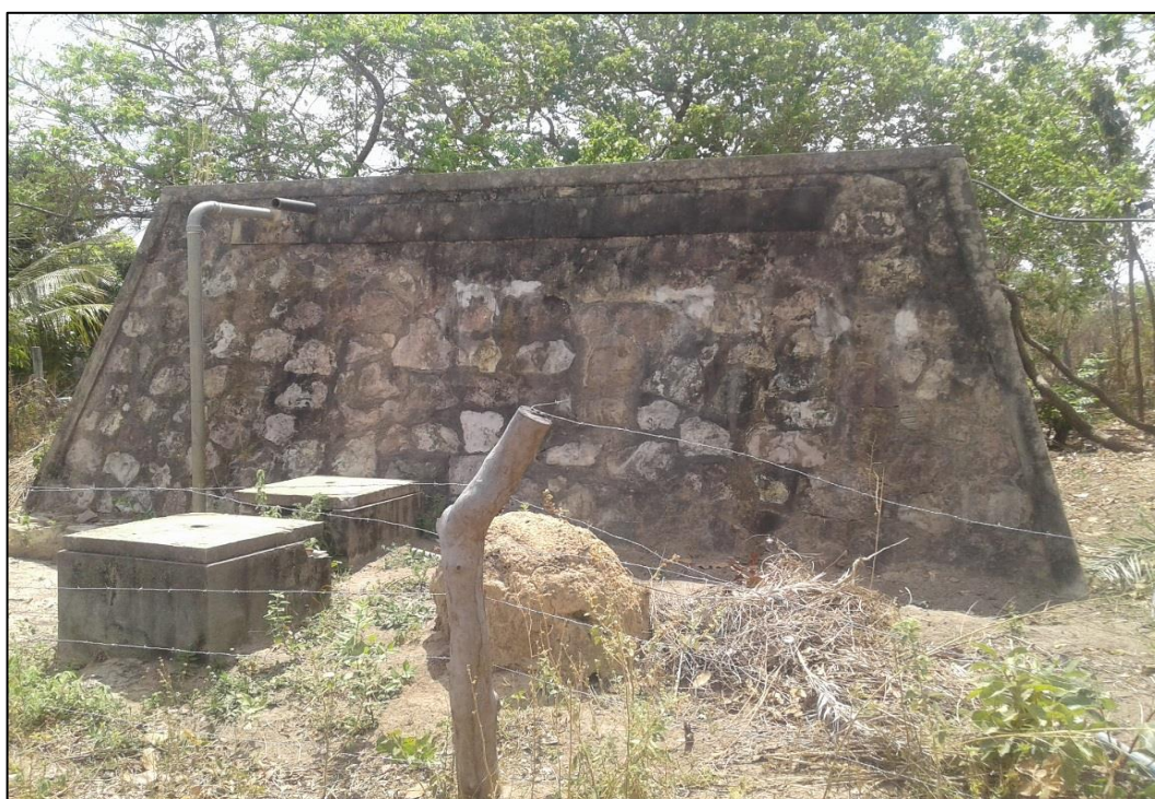
Figura 62 – RAP de pedra do distrito de Inhaúmas. Fonte: DRZ – Geotecnologia e Consultoria, 2017.
