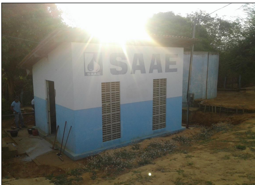
Figura 83 – Casa da bomba de recalque do povoado Cuscuzeiro.
