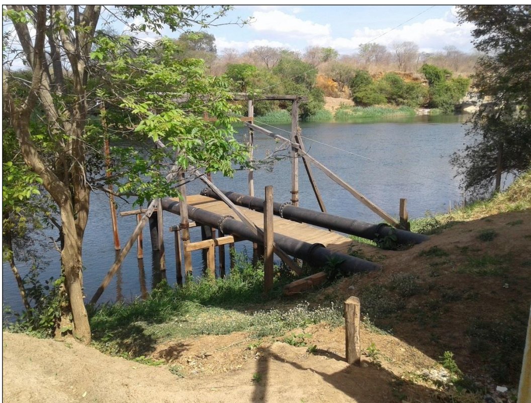
Figura 25 – Área ao entorno da captação superficial no Rio Corrente - Distrito Sede. Fonte: DRZ – Geotecnologia e Consultoria, 2017.
