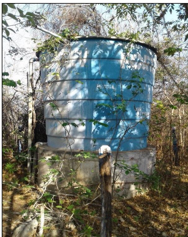
Figura 71 – REL 2 do povoado Água Quente. Fonte: DRZ – Geotecnologia e Consultoria, 2017.
