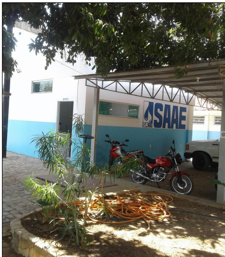
Figura 36 – Vista lateral do prédio da ETA. Fonte: DRZ – Geotecnologia e Consultoria, 2017.
