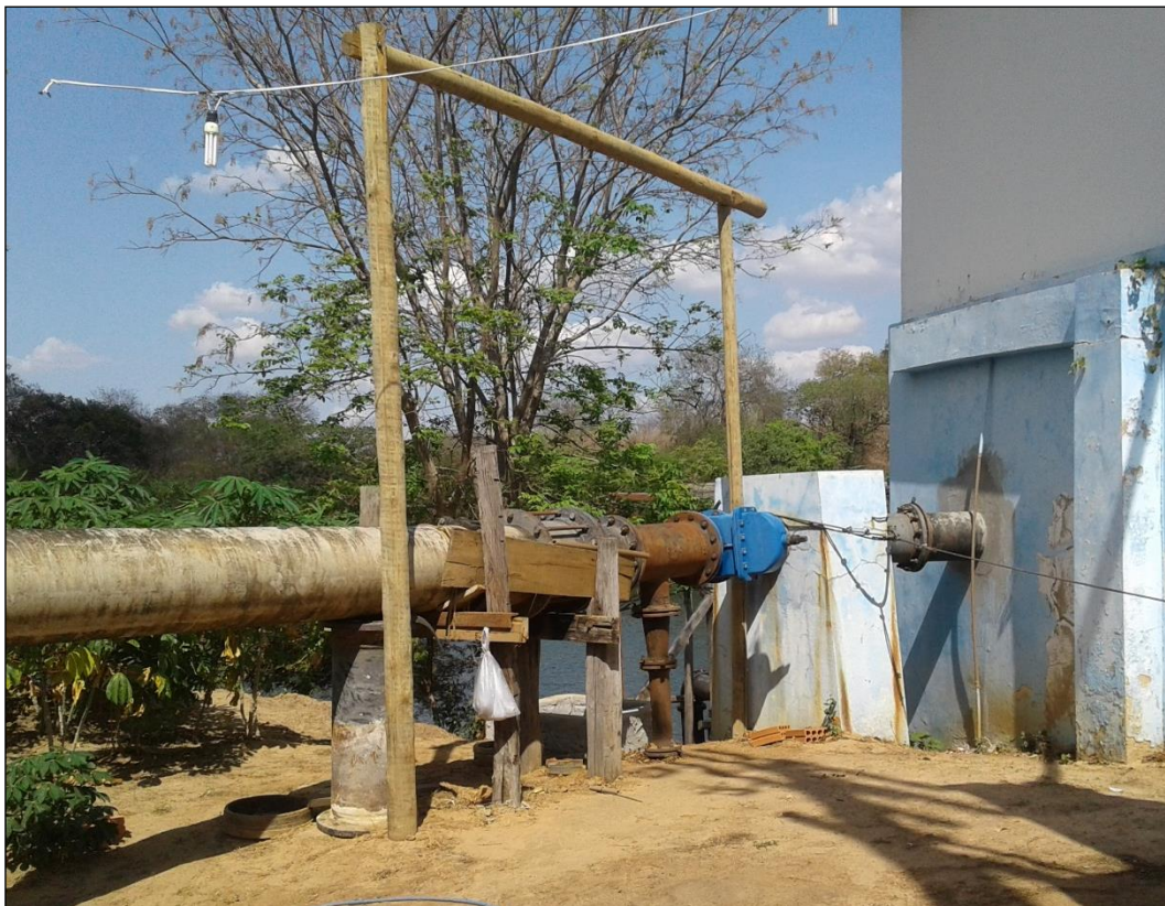
Figura 32 – Reparos na Adutora de Água Bruta.
