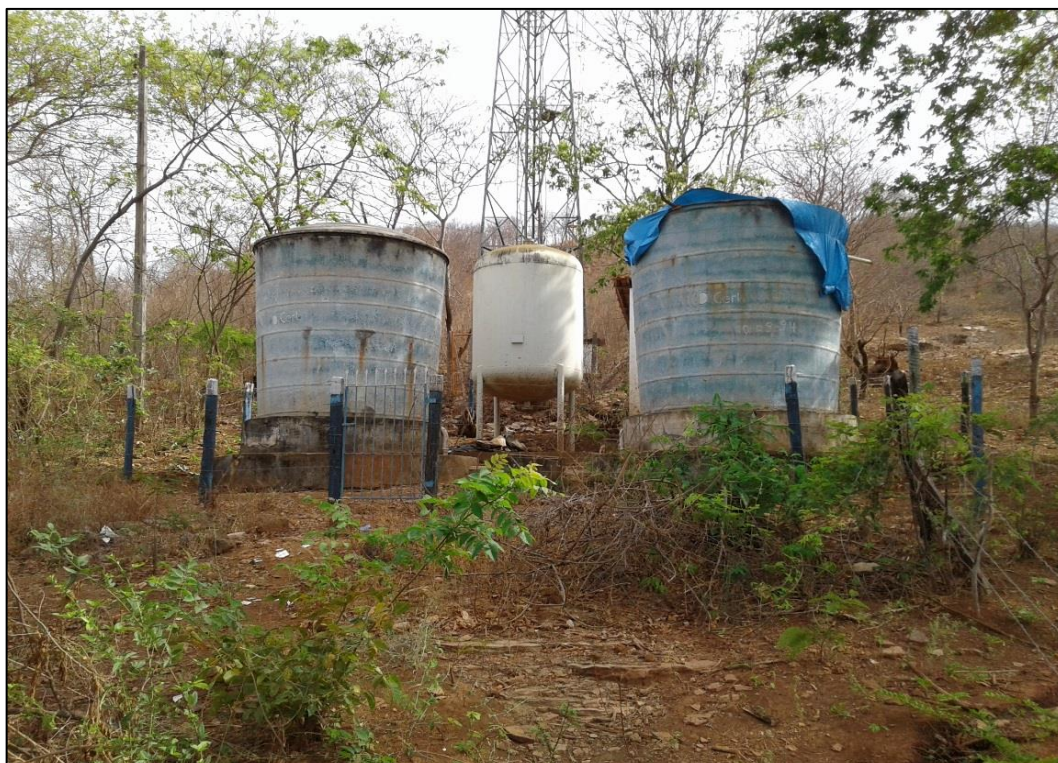
Figura 95 – RAP 1 e RAP 2 de fibra de vidro do povoado de Nova Franca. Fonte: DRZ – Geotecnologia e Consultoria, 2017.
