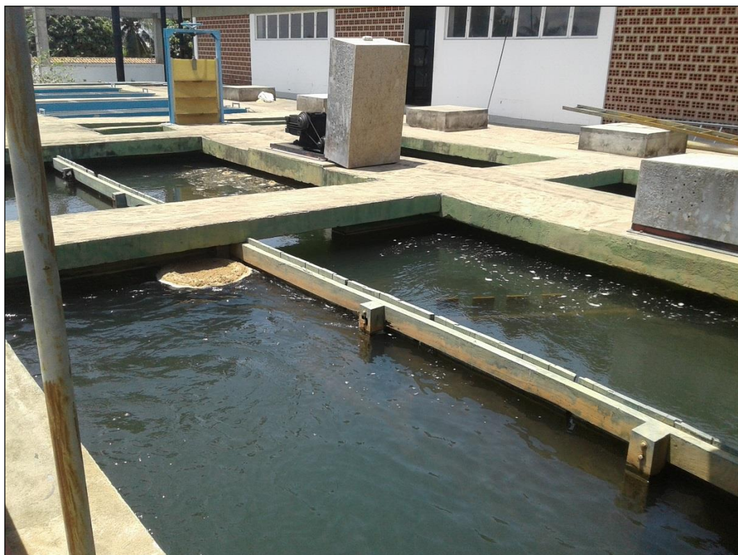
Figura 38 – Floculadores da ETA: Distrito Sede. Fonte: DRZ – Geotecnologia e Consultoria, 2017.
