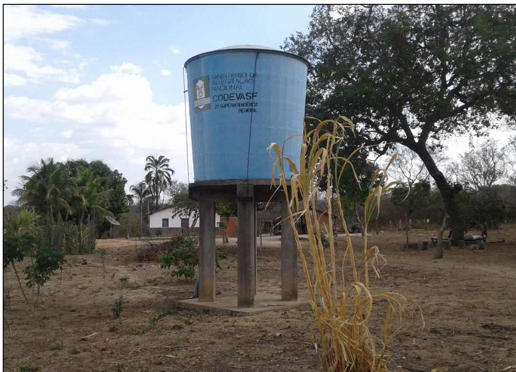
Figura 64 – REL 2 de fibra de vidro do distrito de Inhaúmas. Fonte: DRZ – Geotecnologia e Consultoria, 2017.
