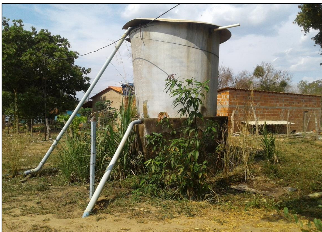
Figura 63 – REL 1 de fibra de vidro do distrito de Inhaúmas. Fonte: DRZ – Geotecnologia e Consultoria, 2017.
