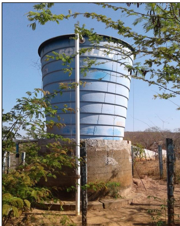
Figura 76 – REL 4 do povoado Água Quente. Fonte: DRZ – Geotecnologia e Consultoria, 2017.
