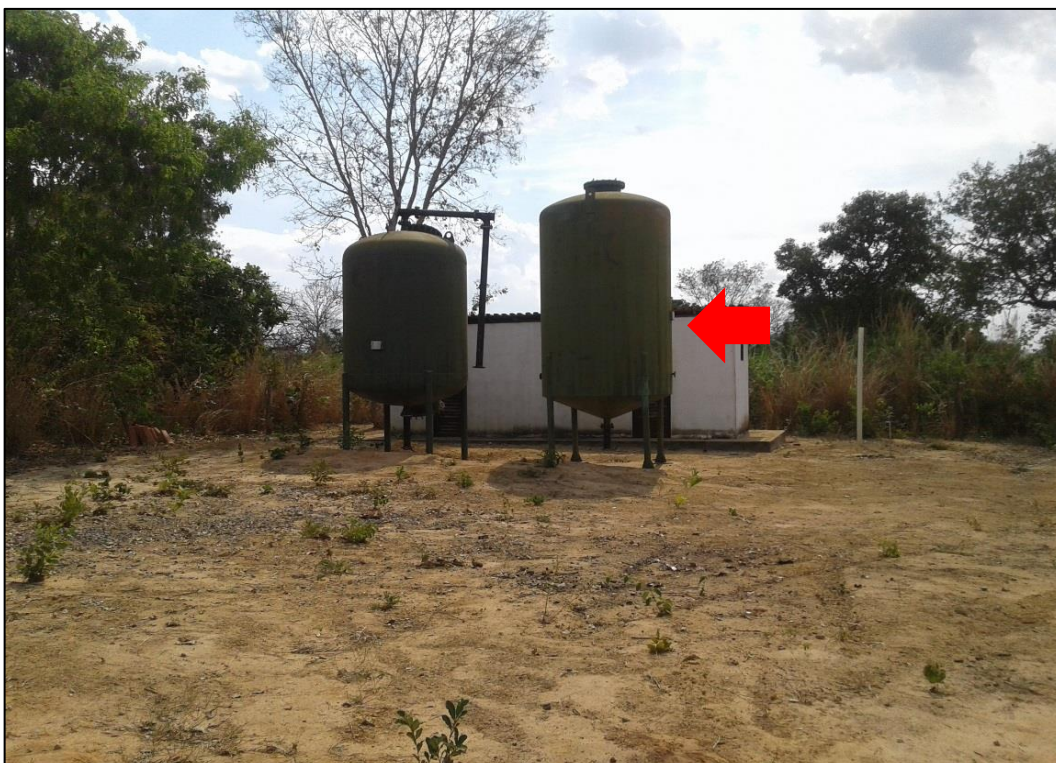
Figura 59 – Filtro Russo desativado do distrito de Inhaúmas. Fonte: DRZ – Geotecnologia e Consultoria, 2017.
