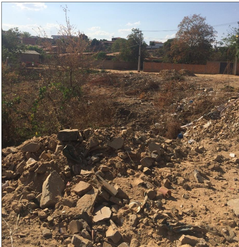
Figura 158 - Erosão da Bairro Centro. Fonte: DRZ – Geotecnologia e Consultoria, 2017.
