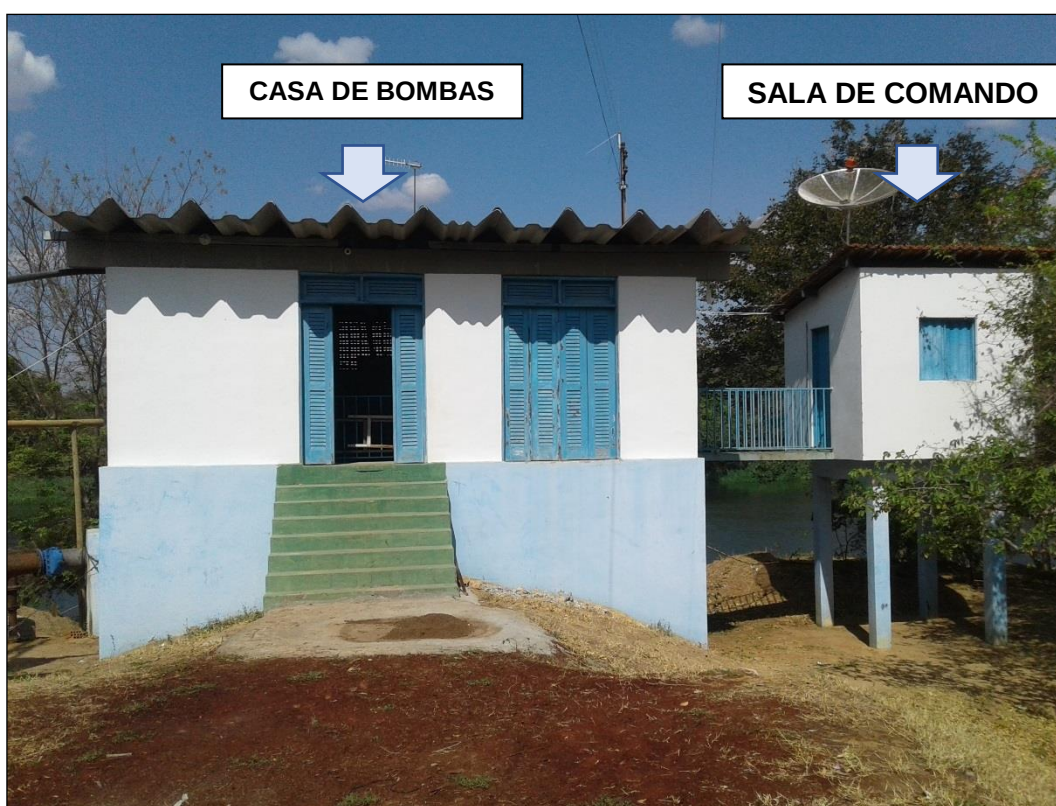
Figura 26 – Casa de bombas e sala de comando. Fonte: DRZ – Geotecnologia e Consultoria, 2017.
