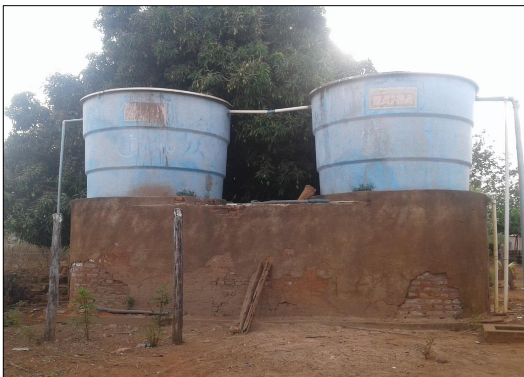
Figura 99 – REL 3 e REL 4 de fibra de vidro do povoado Ponte Velha. Fonte: DRZ – Geotecnologia e Consultoria, 2017.
