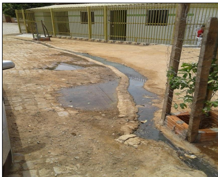
Figura 118 – Lançamento de esgoto em via pública – Comunidade de Mucambo Fonte: DRZ Geotecnologia e Consultoria, 2017
