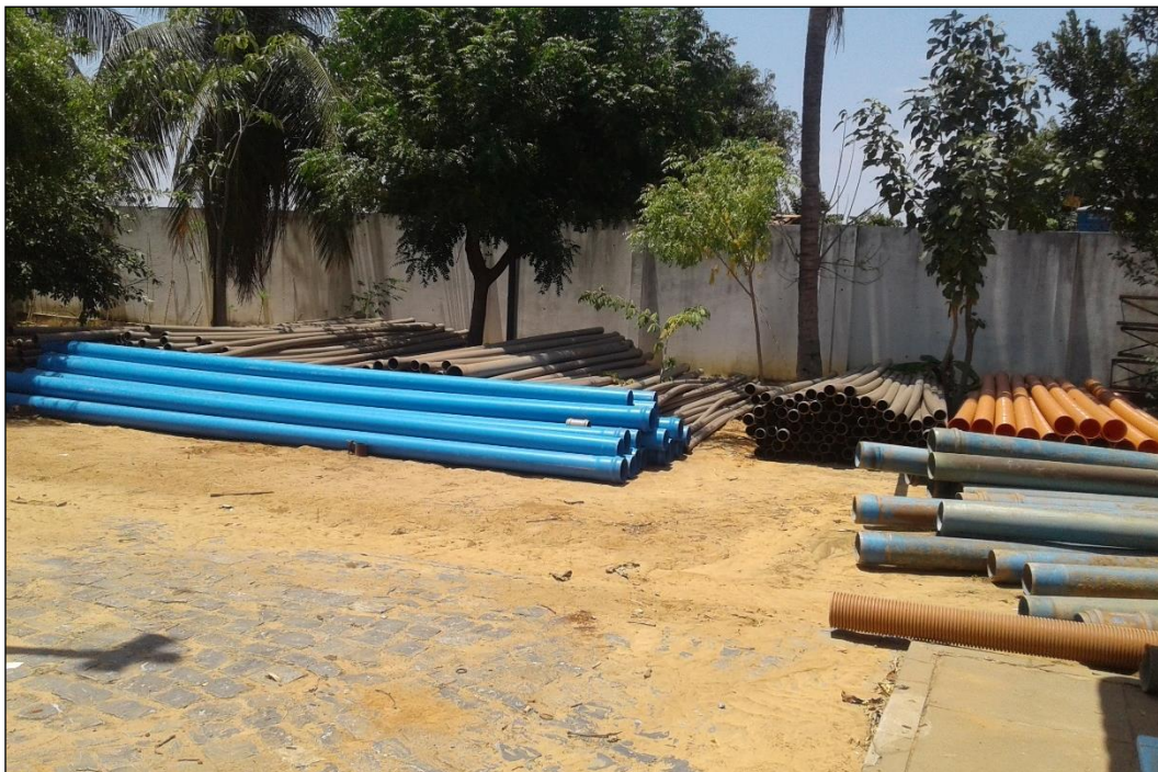
Figura 21 – Tubulações e material a ser reutilizado.
