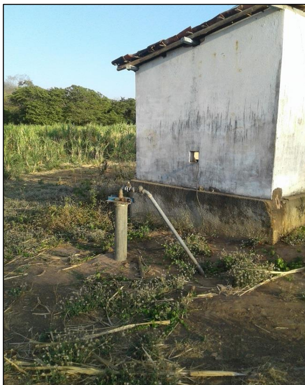
Figura 68 – Captação de poço do povoado Água Quente – P1. Fonte: DRZ – Geotecnologia e Consultoria, 2017.
