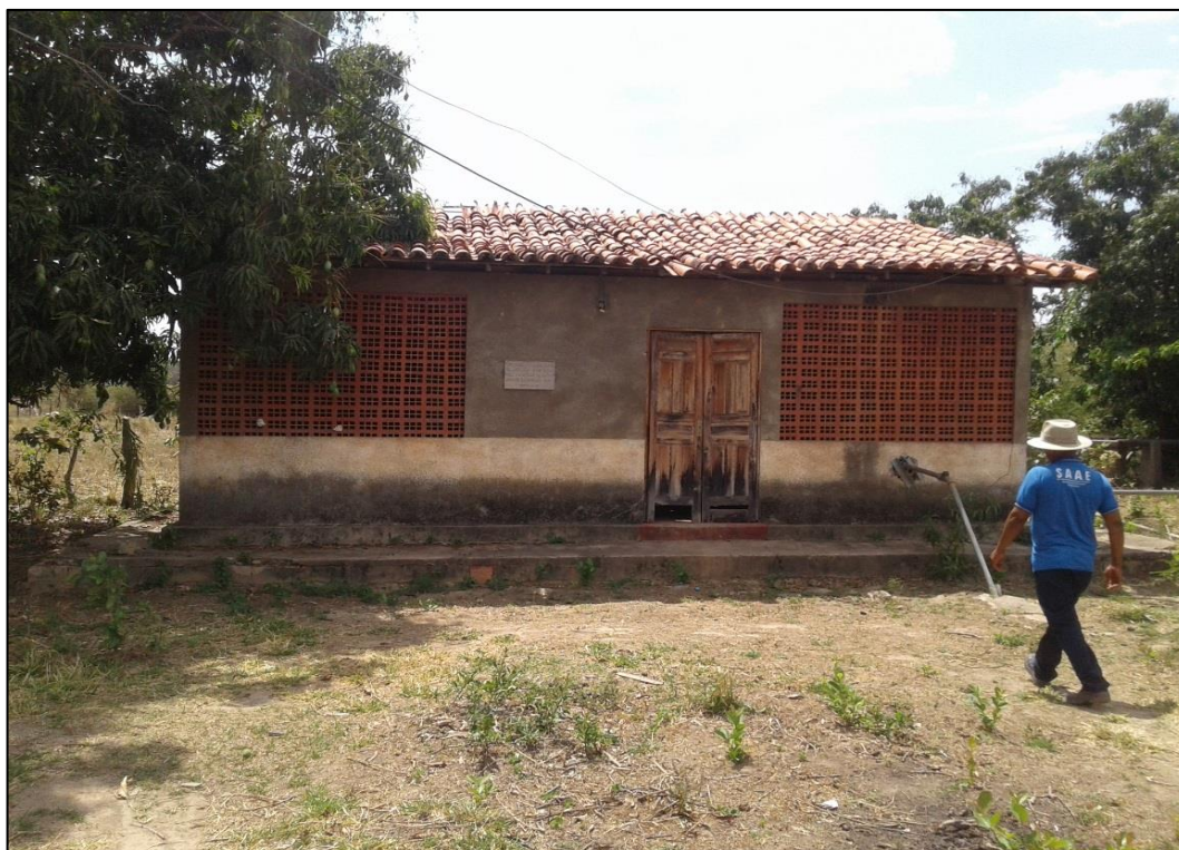
Figura 61 – Estação elevatória (EEA) do distrito de Inhaúmas. Fonte: DRZ – Geotecnologia e Consultoria, 2017.
