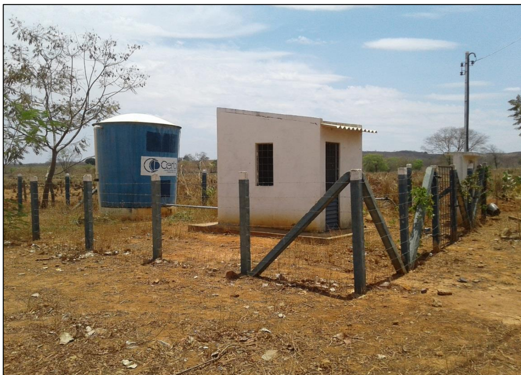
Figura 80 – RAP de fibra de vidro de 10 m 3 do povoado de Caniveta. Fonte: DRZ – Geotecnologia e Consultoria, 2017.
