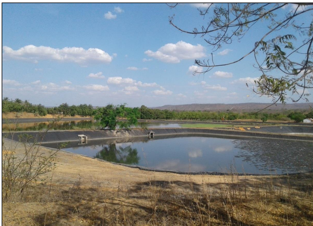
Figura 111 - Lagoas de Tratamento – ETE Fonte: DRZ Geotecnologia e Consultoria, 2017.
