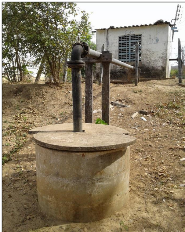
Figura 94 – Captação por bomba superficial do povoado de Nova Franca. Fonte: DRZ – Geotecnologia e Consultoria, 2017.
