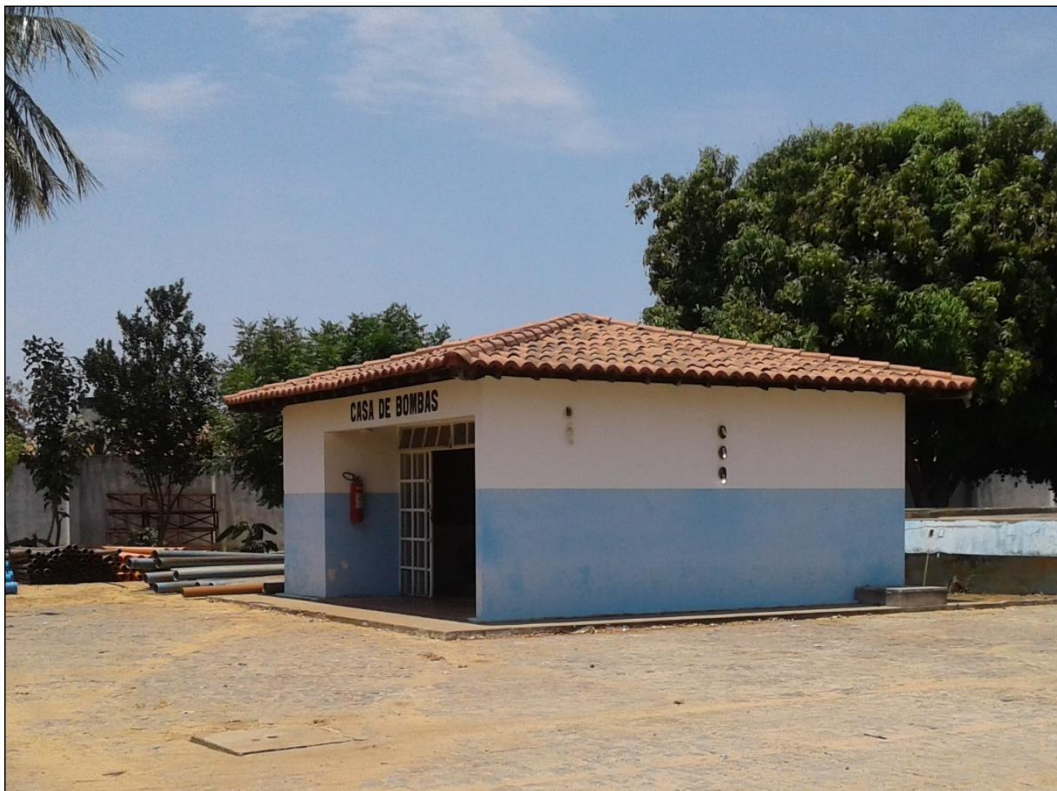
Figura 33 – Casa de bombas EEAT. Fonte: DRZ – Geotecnologia e Consultoria, 2017.
