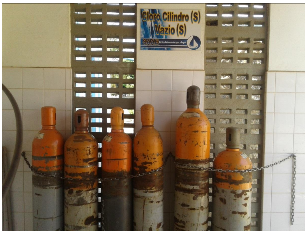
Figura 47 – Depósito de cilindros de cloro gás. Fonte: DRZ – Geotecnologia e Consultoria, 2017.
