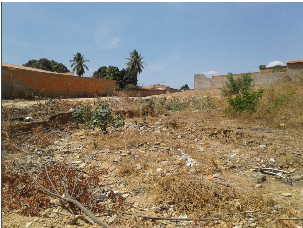
Figura 156 - Erosão próxima a área da Associação Atlética do Banco do Brasil. Fonte: DRZ – Geotecnologia e Consultoria, 2017.
