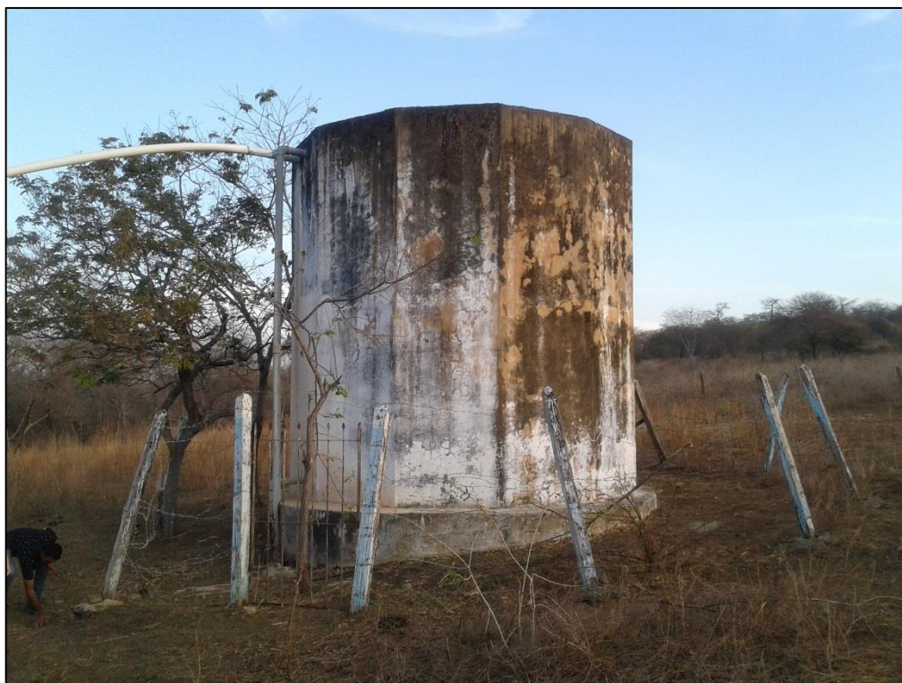
Figura 55 – RAP de concreto do distrito de Açudina.
