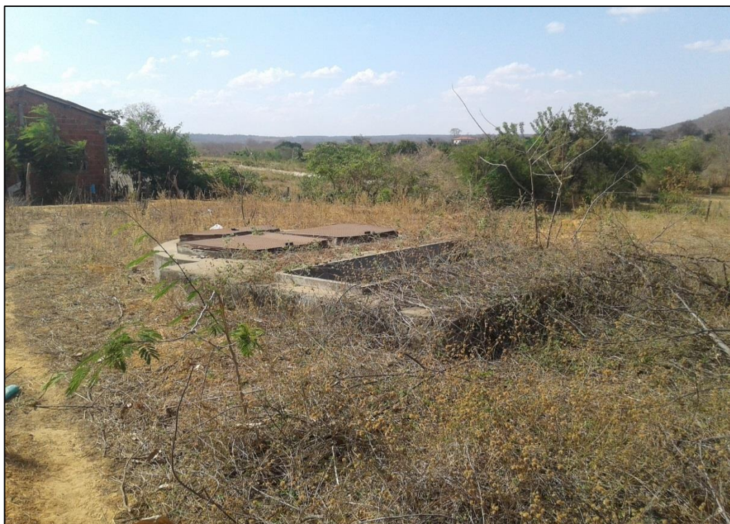
Figura 107 - EEE 3 - Bairro Samambaia Fonte: DRZ Geotecnologia e Consultoria, 2017.
